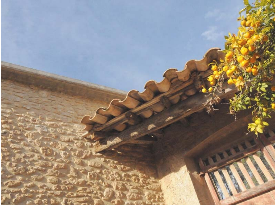
Vista del porche de entrada
